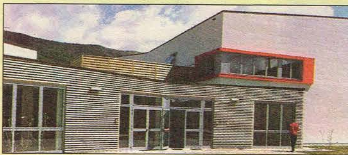
La struttura polifunzionale nel polo universitario di Coppito
